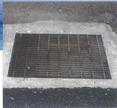
グレーチングまわり
